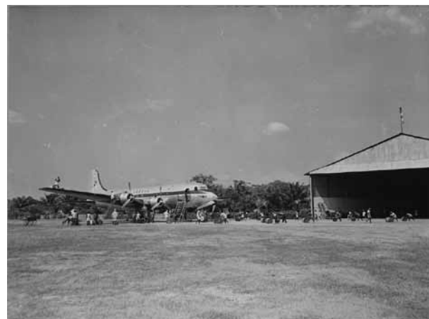
III. 14.11. Un aspect de l'aérodrome de Libenge, 1951. La piste d'envol, longue de 2200 m, est accessible aux avions internationaux. (HP.1956.15.13410, collection MRAC Tervuren ; photo J. Mulders [Inforcongo], 1951, MRAC Tervuren ©.)
